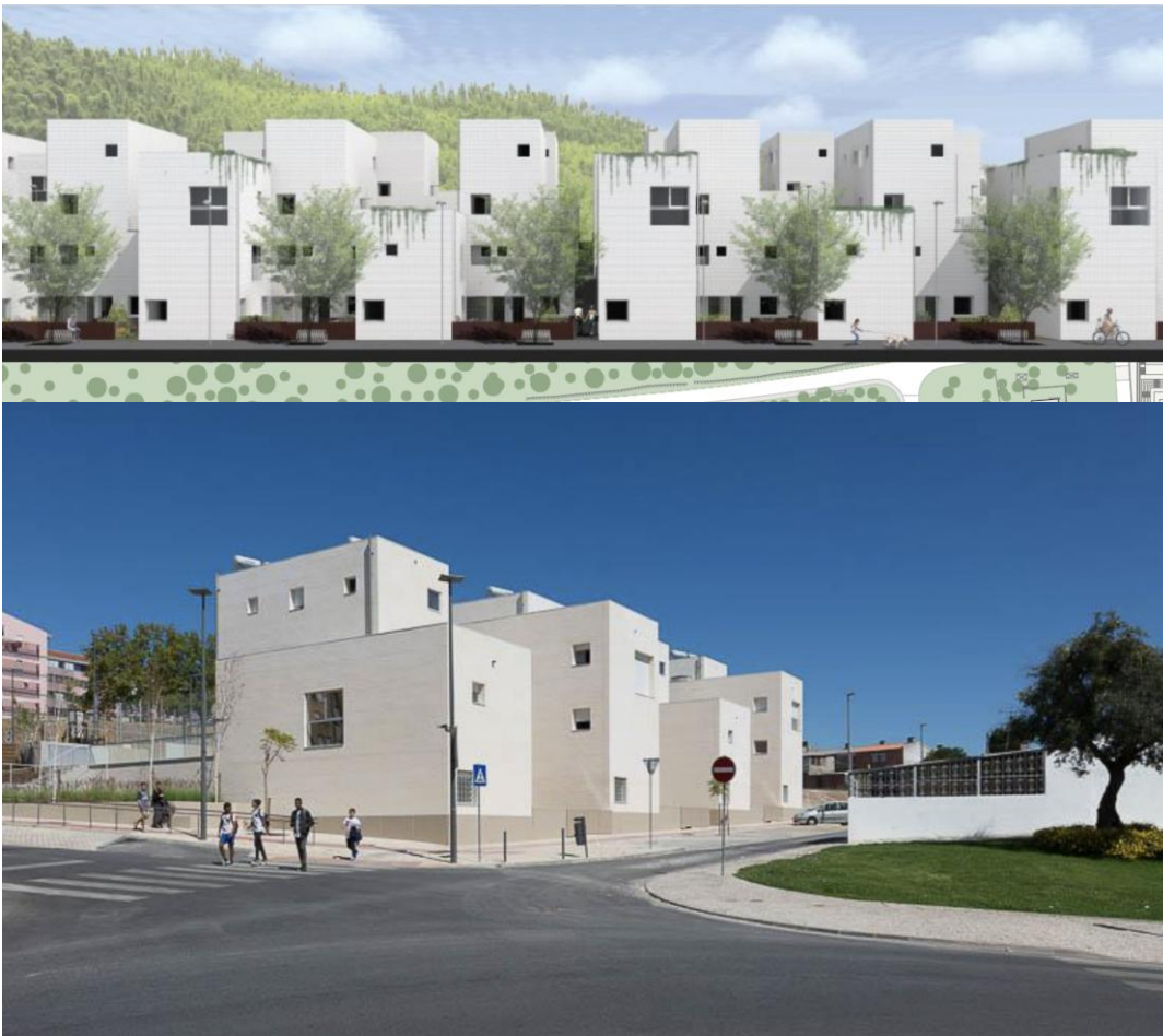
Construções sociais ecologicamente sustentáveis no Bairro Padre Cruz, Carnide (Fotos Rui Franco)
