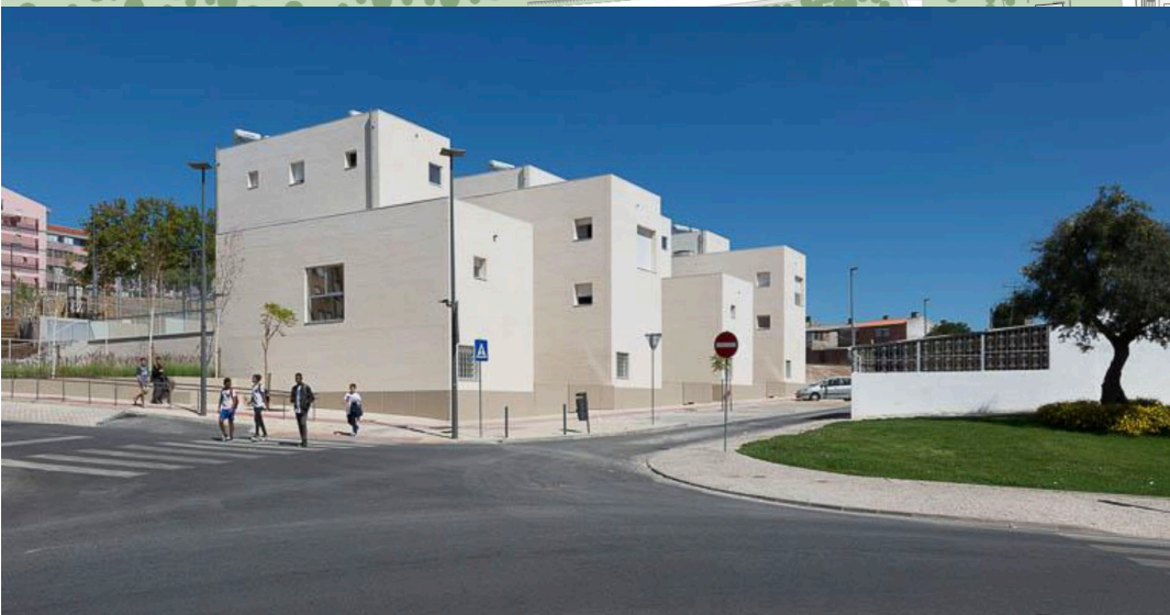
Budownictwo ekologiczno-społeczne na osiedlu Bairro Padre Cruz, Carnide (Zdj. Rui Franco).
